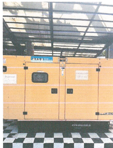
รูปภาพที่ 2.18 เครื่องสำรองไฟฟ้า (Generator)
